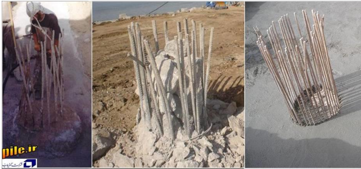
تخریب بتن کثیف روی شمع بعد از ۷ روز
