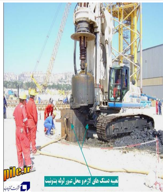
تعبیه دستک و محل عبور لوله بنتونیت
