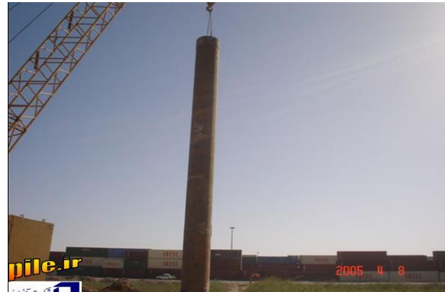
خارج کردن کیسینگ بعد از اتمام بتن ریزی
