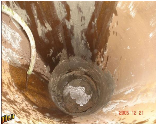
قرارگیری کیسینگ در دهانه شمع
