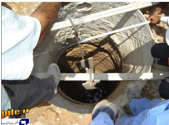
شاقول کردن پروفیل برای قرار گرفتن در مرکز شمع
