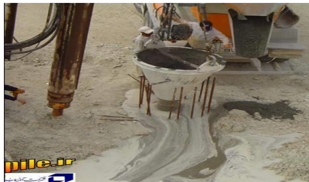
سر ریز شدن بنتونیت بعد از بالا آمدن بتن در هنگام بکاربری گل بنتونیت
