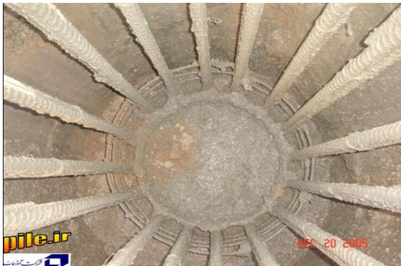
انتهای لوله ترمی نباید از درون بتن خارج شود
