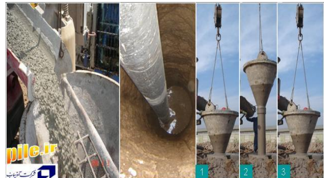
بالا و پایین کردن ترمی جهت تخلیه بتن درون آن
