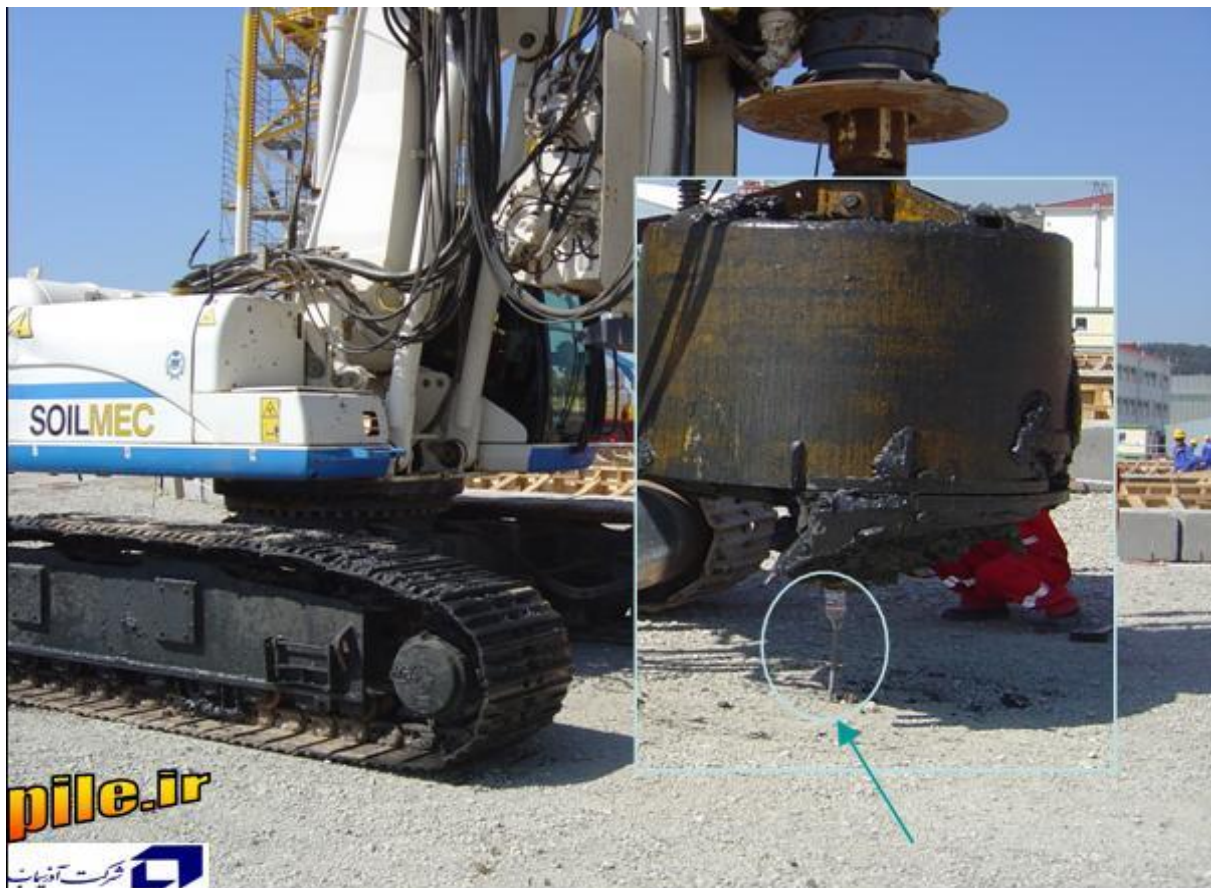
تراز کردن مته حفاری با محل شمع
