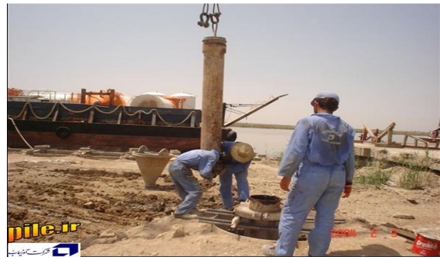
کوتاه کردن لوله ترمی به دلیل بالا آمدن بتن
