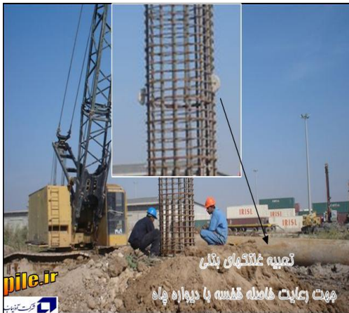
تعبیه غلتکهای بتنی جهت رعایت فاصله طولی
