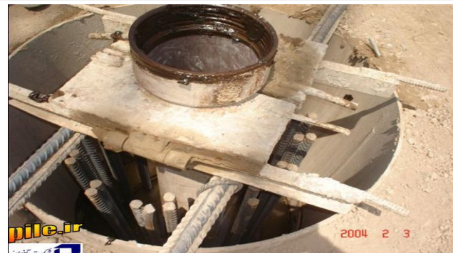
نگه داشتن ترمی در دهانه چاه جهت نصب قیف
