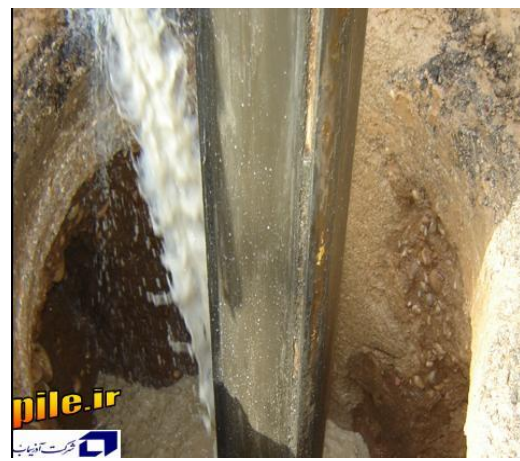
تزریق دوغاب بنتونیت به چاه در حین حفاری
