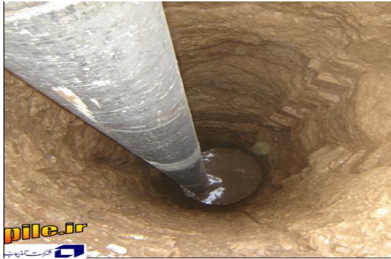
انتهای لوله ترمی نباید از درون بتن خارج شود
